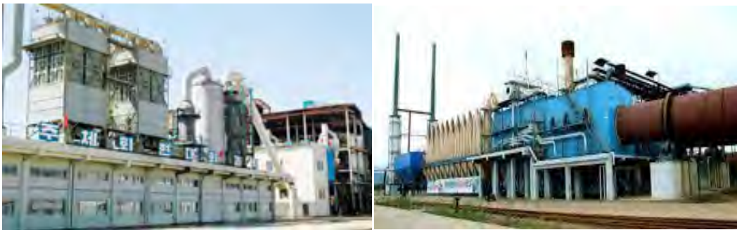
[그림 IV-2-8] 단천제련소 건물 및 신규 건설된 산화아연 생산공정
