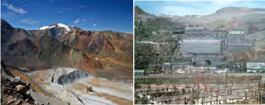
[그림 VI-1-8] 무산광산 전경 및 연합기업소 건물
