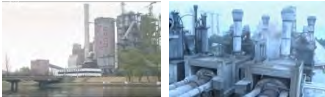
[그림Ⅳ-6-6] 상원시멘트연합기업소 건물 및 설비
