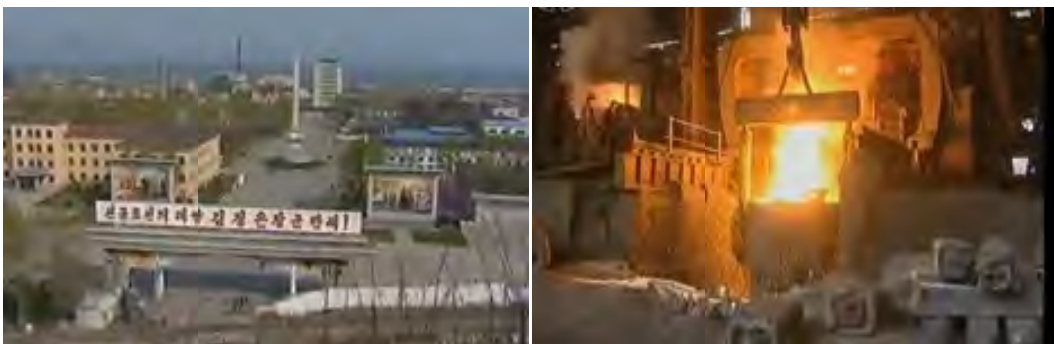
[그림Ⅳ-1-12] 성진제강연합기업소 건물 및 설비
