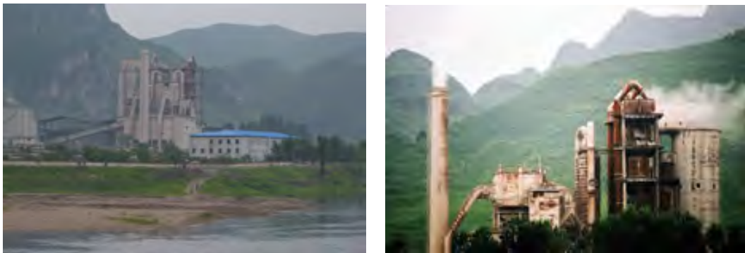
[그림 IV-6-18] 만포(8.2)시멘트공장 건물 및 설비
