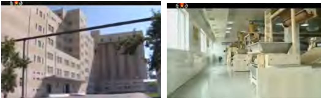
[그림 V-4-5] 평양밀가루종합가공공장 건물 및 설비
