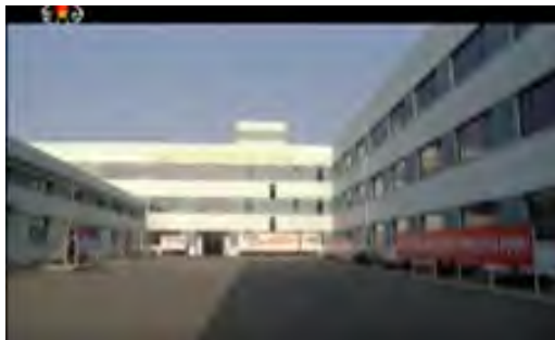
[그림 V-2-12] 류원신발공장 건물 및 설비
