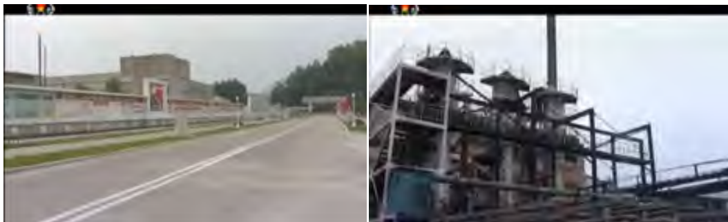
[그림Ⅳ-2-18] 문천금강제련소 건물 및 설비
