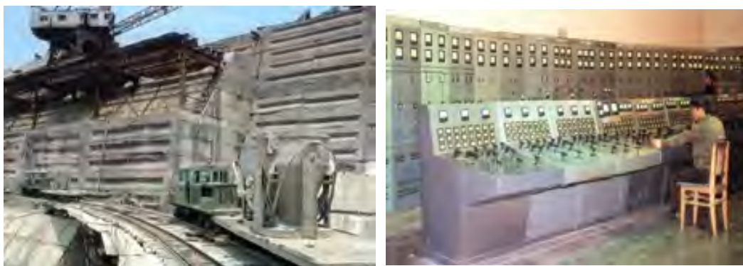
[그림 Ⅲ-4-4] 태천2호발전소 언제(堰堤) 및 발전소 배전실
