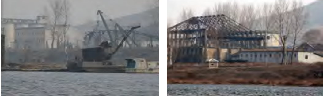
[그림Ⅳ-5-7] 청수화학공장 건물 및 설비
