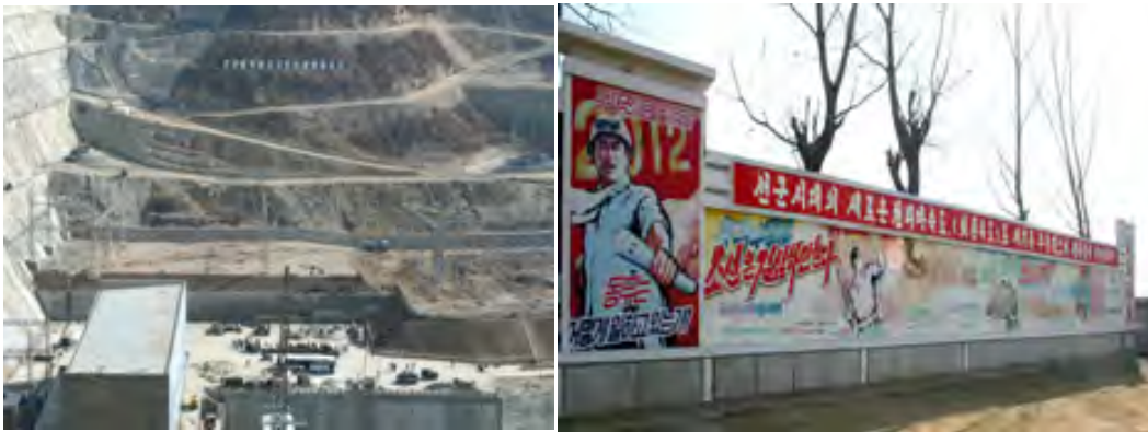
[그림 Ⅲ-4-10] 희천발전소 건설 현장
