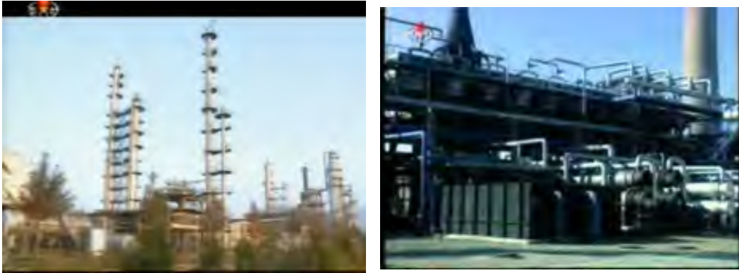
[그림Ⅳ-5-15] 봉화화학공장 건물 및 설비
