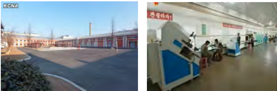
[그림 V-2-10] 원산구두공장 건물 및 설비
