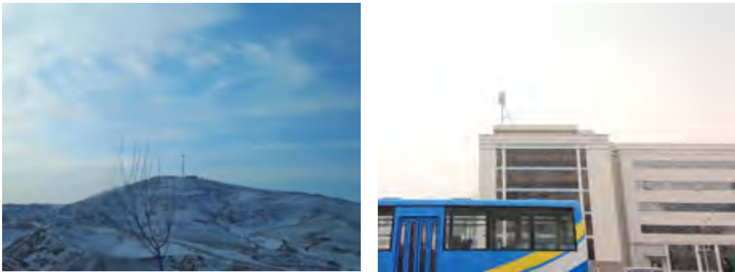
[그림 V-6-7] 평양-개성 고속도로 주변의 중계탑 및 평양시내 상업시설에 설치된 기지국
