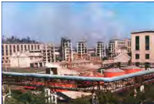
[그림 V-1-3] 2.8비날론연합기업소 건물 및 설비
